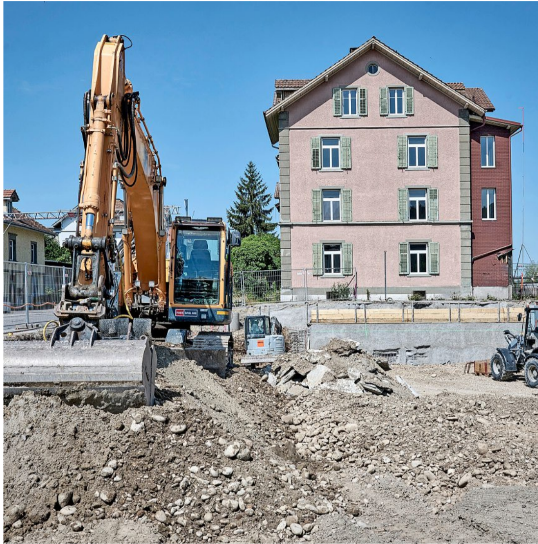
Seit ein paar Tagen sind die Bauarbeiten auf der Fläche an der Ecke Bucherstrasse/Lyssachstrasse im Gang. 2023 soll hier unter anderem eine Gruppenpraxis den Betrieb aufnehmen. Foto: Adrian Moser
