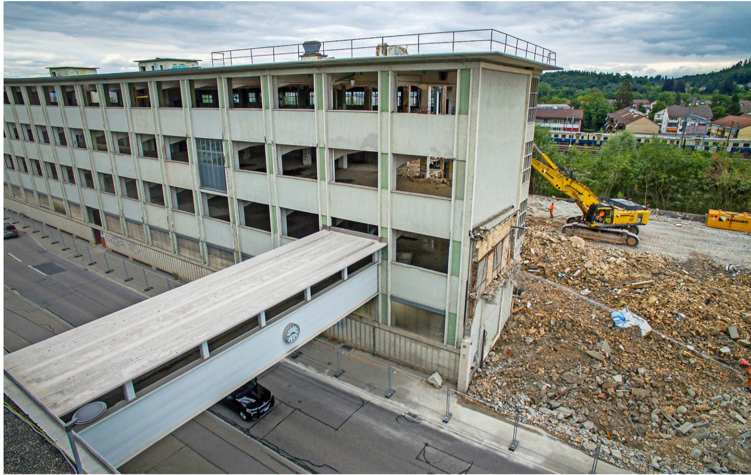
Die Passerelle über die Lyssachstrasse wird bereits Ende Juli abgebrochen, der Industriekomplex der früheren Burgdorfer Maschinenfabrik Aebi soll Ende August verschwunden sein. Foto: Marcel Bieri
